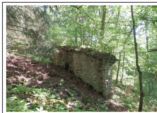
Už jen kusy zdí zbyly z hrádku nad Unterthürnau Foto: R. Zeman
